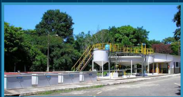
Figura 7: Laboratório de Caracterização Analítica e Tratamento de Efluentes do DEQUI
